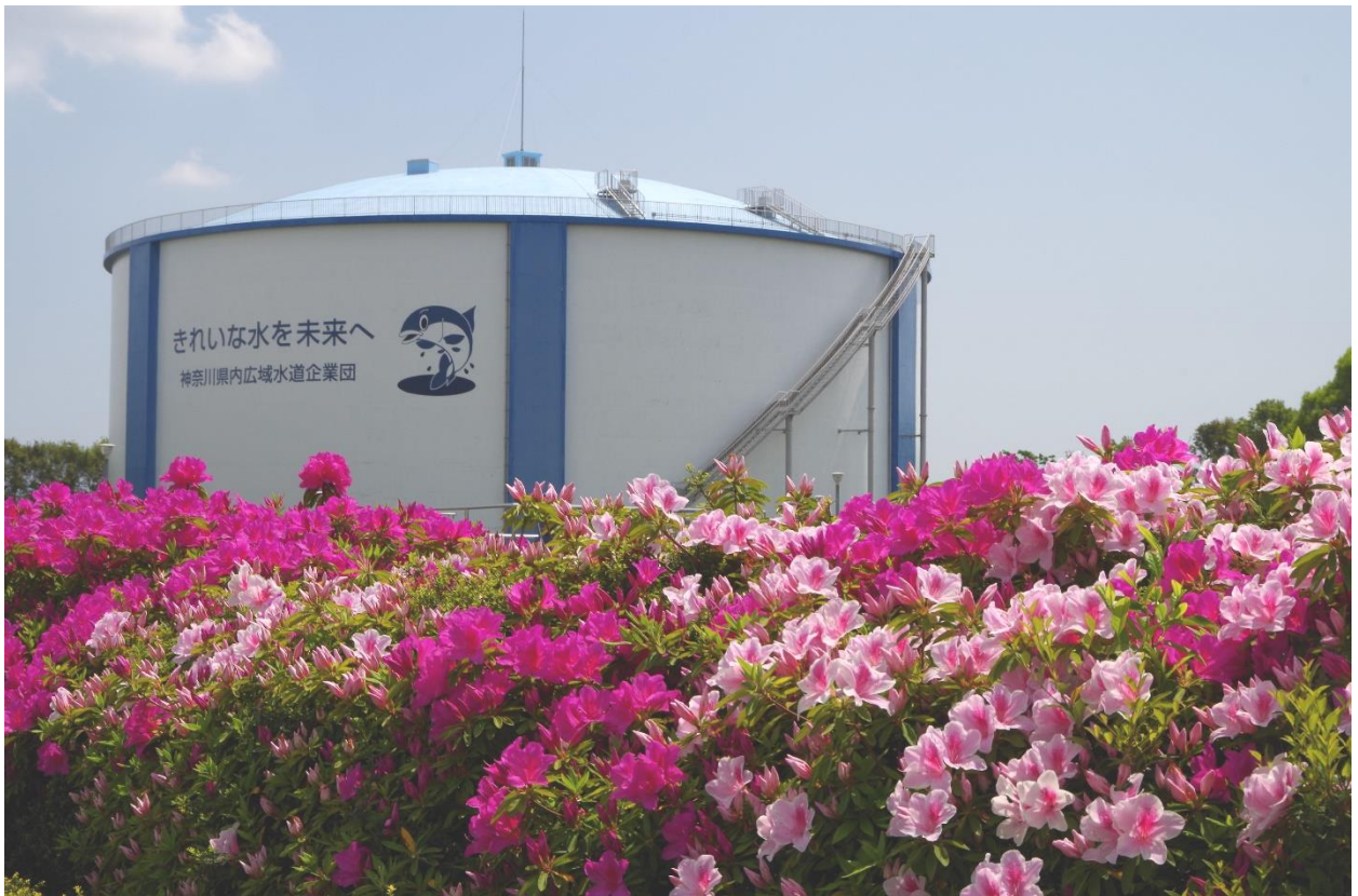
(相模原浄水場 PC調整池)
