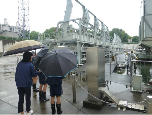
沈砂池の見学（社家取水管理事務所）
