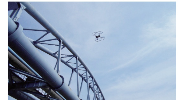
ドローンによる施設点検
