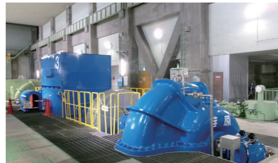
導水ポンプの更新
