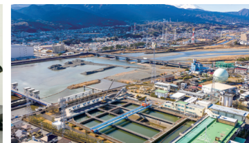
酒匂川から取水している取水管理事務所
