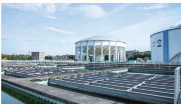
高架調整池が特徴的な浄水場(527,600m3/日)
