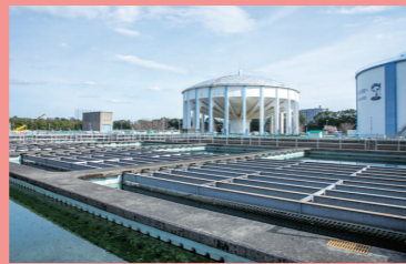
高架調整池が特徴的な浄水場
