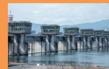
相模川から取水している取水管理事務所
