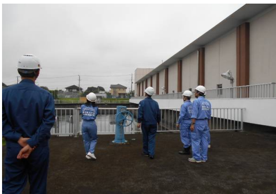
相模原ポンプ場
