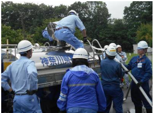
給水車へ給水
