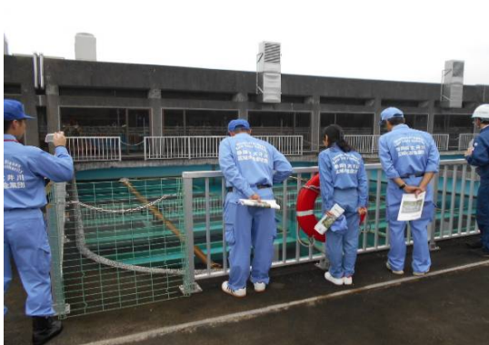
浄水処理施設
