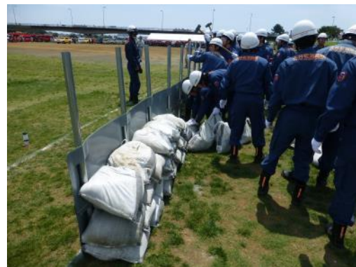
水防工法（鋼板積み土のう）
