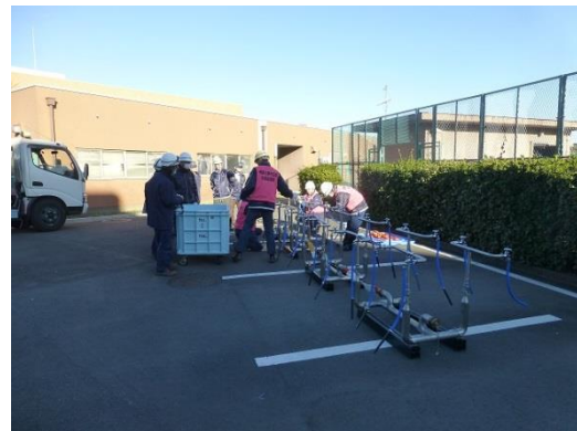
給水栓の組立
