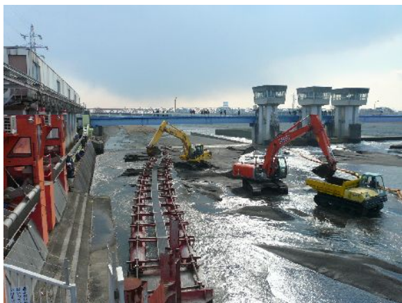
取水口の浚渫作業の様子
