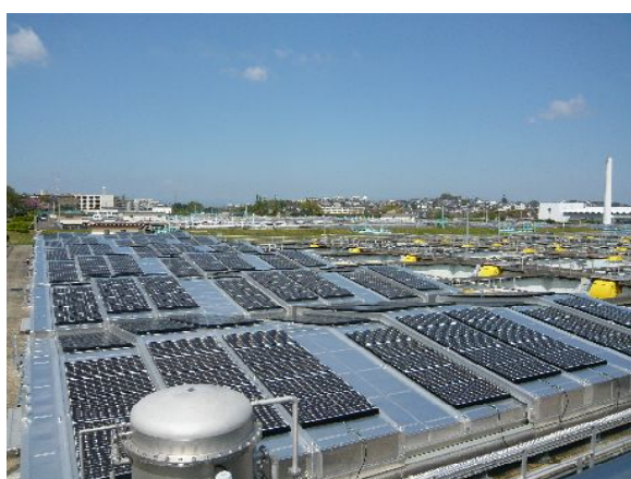
太陽光発電設備の設置（西長沢浄水場）
