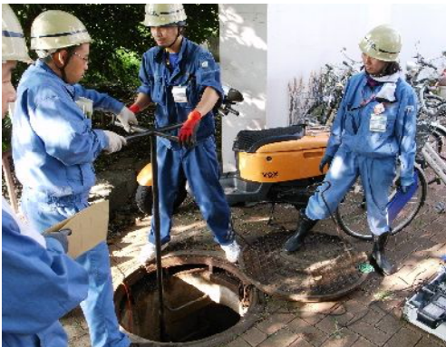
新横浜給水地点での送水管路排水作業実習
