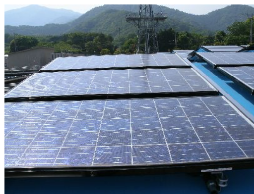
伊勢原浄水場沈でん池等の覆蓋化及び太陽光発電設備の設置
