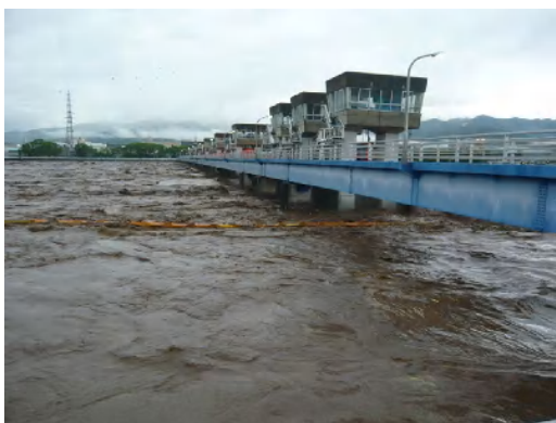
最大流量記録時の飯泉取水堰（左岸から下流側）
