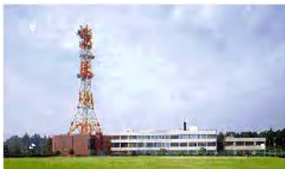
企業団本庁舎・水運用センター及び矢指調整池(手前)
