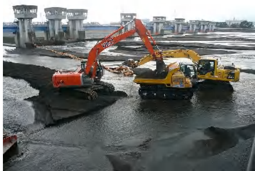
取水口前部の浚渫
