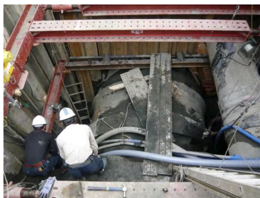
内径 3,100mm 導水管補修作業の状況
