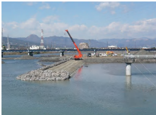
仮設堤防の築造
