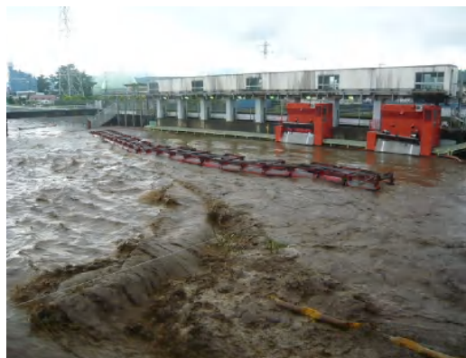
取水口除塵機（右）が損傷
