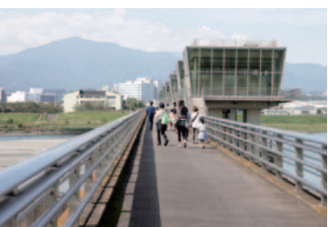
相模大堰の上に行く。ガラス張りの施設は「ゲート操作室」
