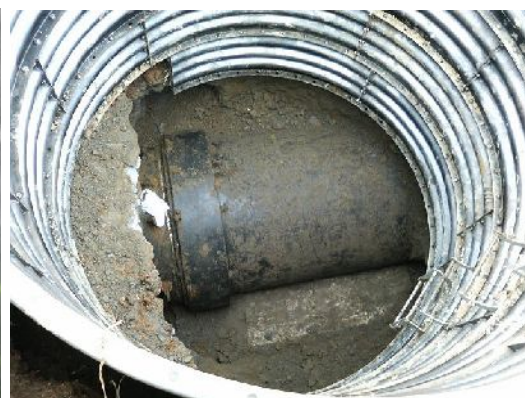
西長沢系送水管路の試掘調査(平成23年度)
