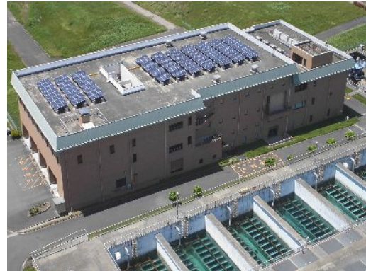
綾瀬浄水場太陽光発電設備
