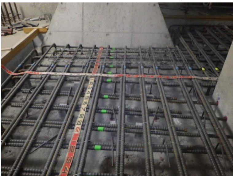
綾瀬調整池の耐震補強（底版増厚）
