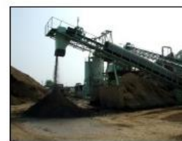
埋め戻し材処理
