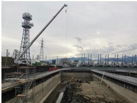
飯泉ポンプ場排砂処理 (沈砂池浚渫の様子)
