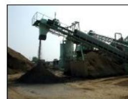
埋め戻し材処理
