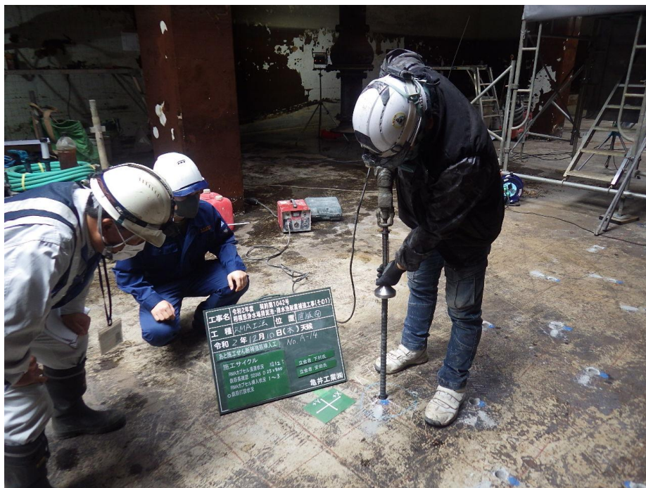
相模原浄水場排泥池・排水池の耐震補強
