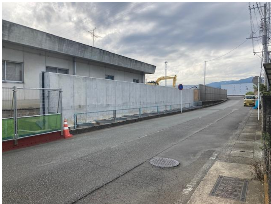
飯泉取水管理事務所の防水壁(施工中)
