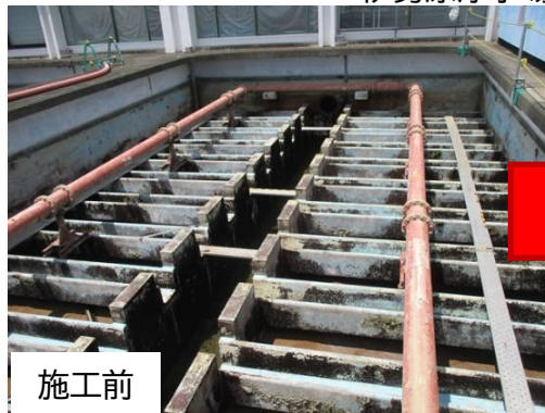
伊勢原浄水場ろ過池(内面塗装)
