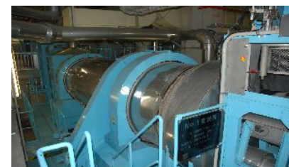
＜綾瀬浄水場排水処理施設＞
