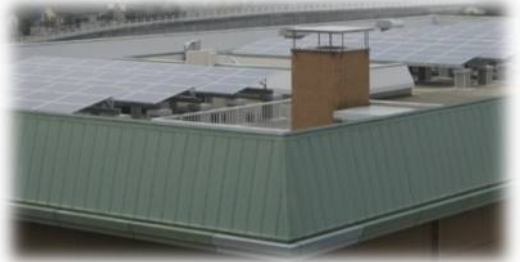
綾瀬浄水場太陽光発電設備
