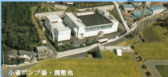
小雀ポンプ場・調整池
