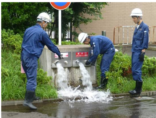
給水口滞留水の排水
