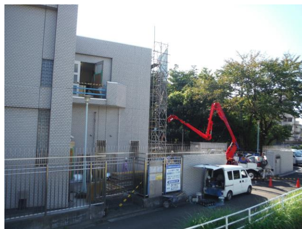
耐震壁コンクリート打設
