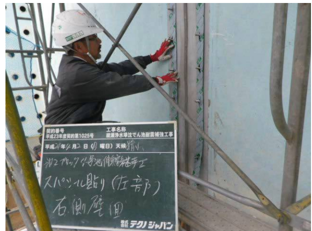
後付型耐震可とう継手設置 (沈でん池)
