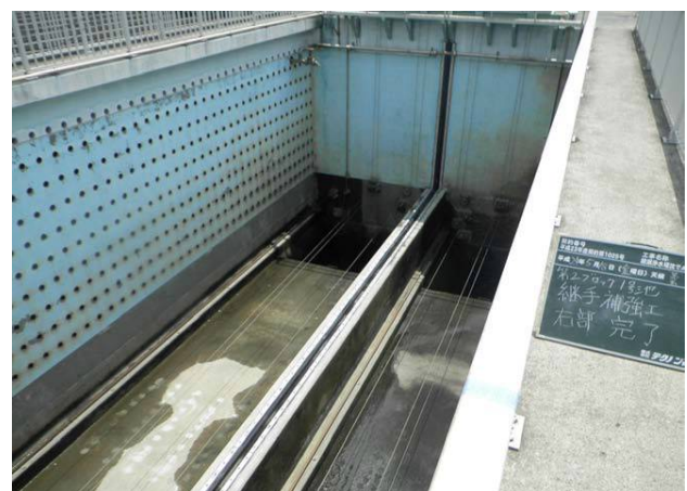
施工完了(沈でん池)
