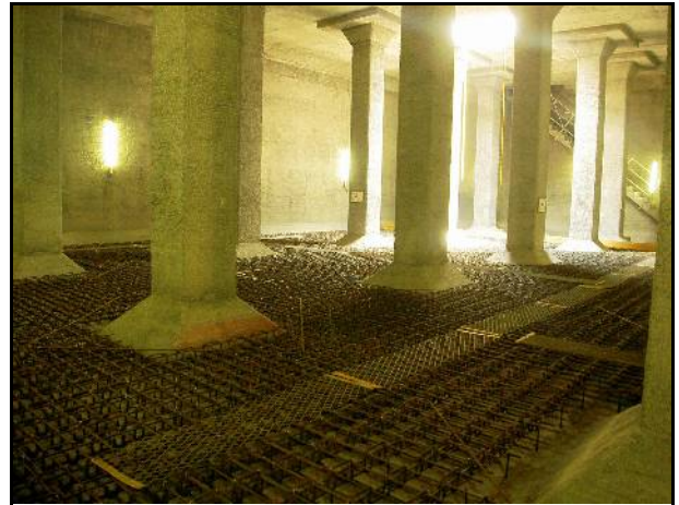
鉄筋組立状況(底版)
