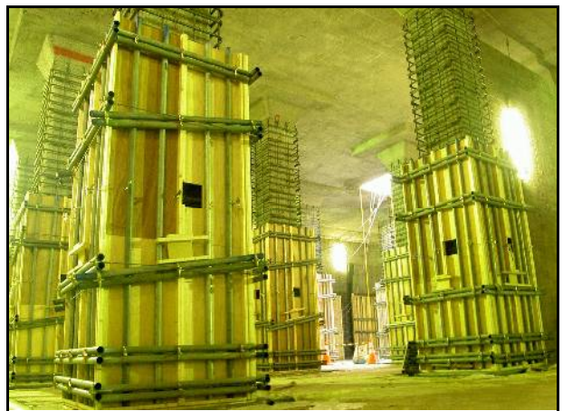
型枠組立状況(柱)
