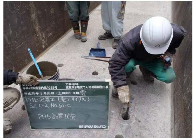
後施工プレート定着型せん断補強筋設置 (沈でん池)
