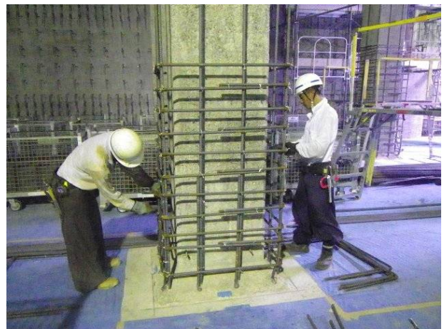
柱部材増厚のための鉄筋組立状況
