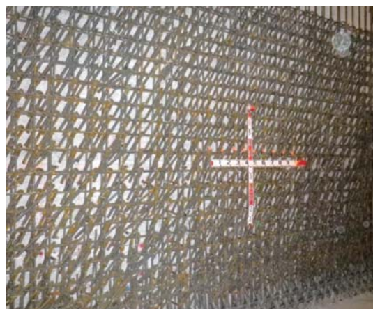
矢指調整池壁側の耐震補強工事の様子
