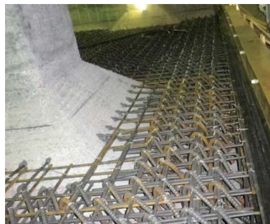
矢指調整池柱の耐震補強工事の様子
