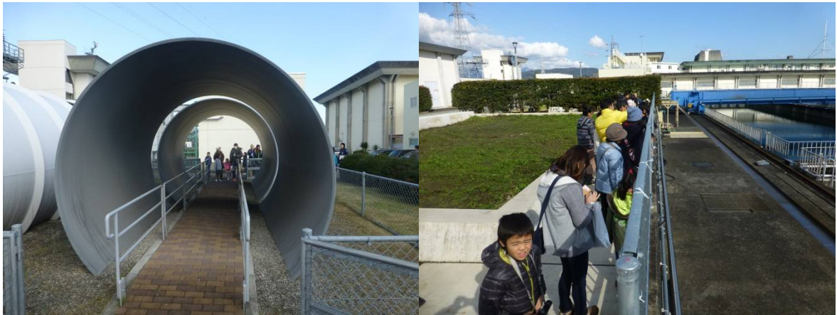
備蓄用導水管（こんなに大きいの！）
