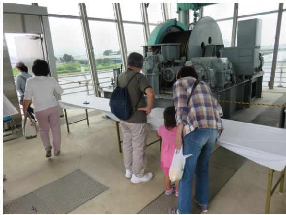
普段見ることができない場所を見学（相模大堰内）
