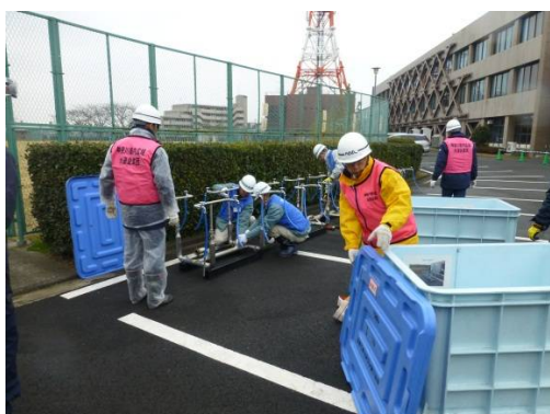
応急給水栓の組立て
