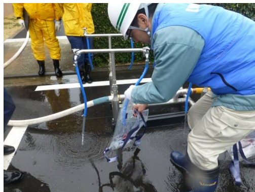
応急給水栓からの給水
