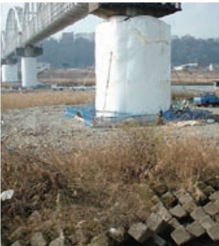
橋脚の鋼板巻き付け補強工事
